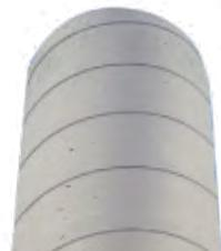
Bei der Verwendung von selbstverdichtendem Beton sind die Betoniergeschwindigkeiten zu halbieren.
