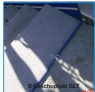
Das Treppenschalldämmelement Typ Z dient zur schalltechnischen Trennung zwischen Treppenlauf und Treppenpodest. In Kombination mit der Fugenplatte K bzw. dem Treppenschalldämmelement Typ B ergibt sich ein Schallschutzsystem für den schallbrückenfreien Einbau von Treppen.
