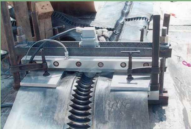
III Vulkanisationsprozeß (Stoßverbindung auf der Baustelle). Vulcanization (bonding of joints on site).
