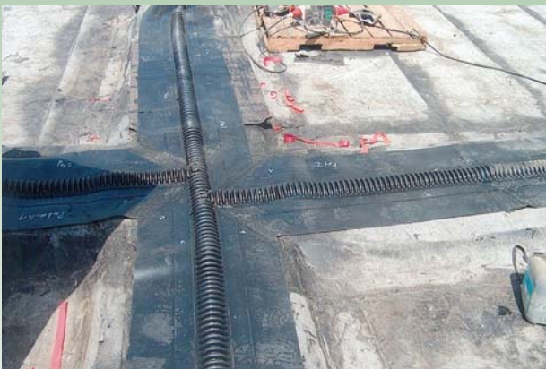
IV Fertiges System (werkseitig vorgefertigtes Formstück einschl. der bauseits durchgeführten Stumpf-Vulkanisa- tionen) vor dem Aufbringen der Flächenabdichtung. Finished system (factory-made moulding together with butt joint vulcanization on site) before application of the surface sealing.
