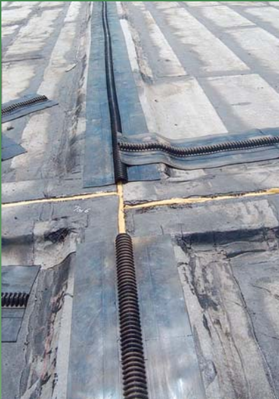
I Situation vor der Vulkanisation der Stumpfstoße, Meterware bereits verlegt. Before vulcanization of the butt joints, cut-length waterstops already laid.
